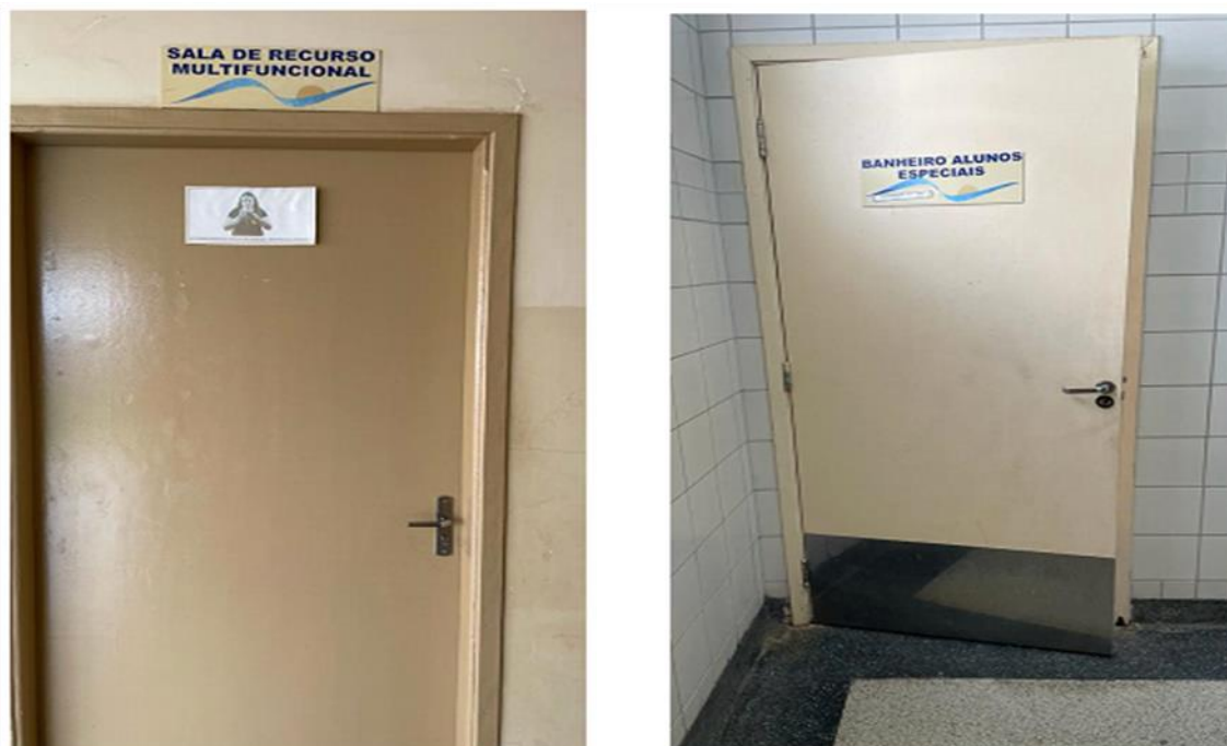
Figura 15 – Banheiro acessível – Identificação Libras – ETI Ana Lúcia de Oliveira Batista
