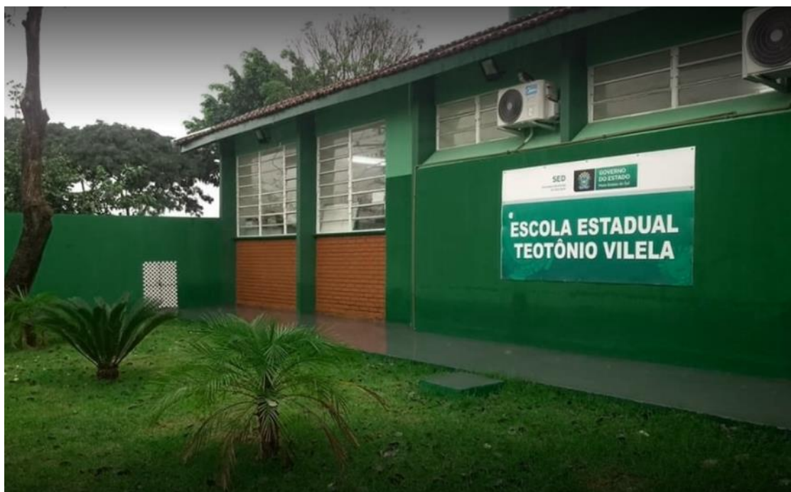
Figura 7 – Fachada da Escola Estadual Teotônio Vilela
