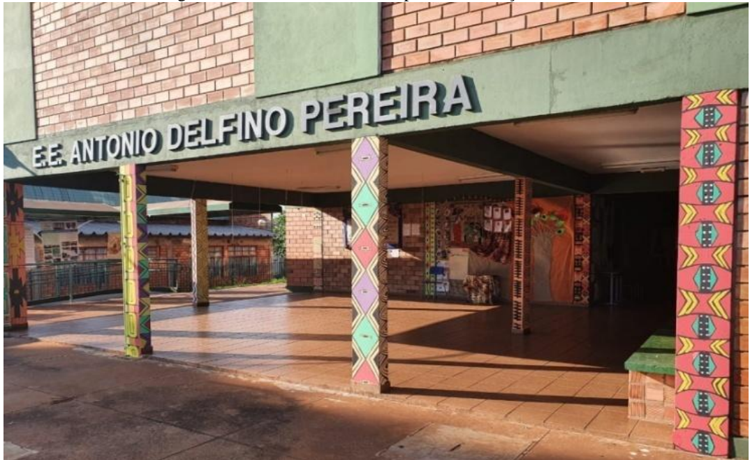
Figura 10 – Fachada da Escola após a intervenção - 2020
