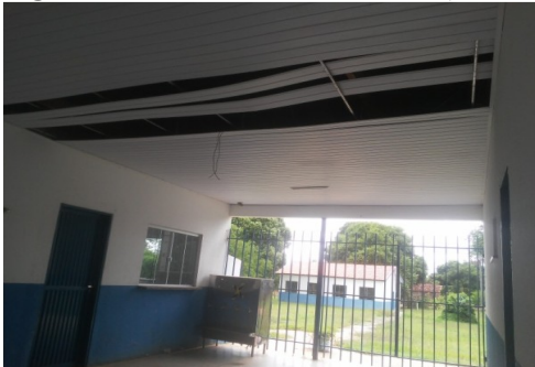
Figura 25 – Escola Feliciano Pio (antes da reforma)
