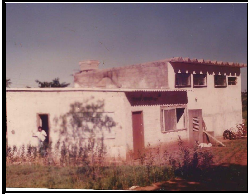
Figura 16: Construção da sala dos professores e da secretaria da Escola Agrícola, 1992
