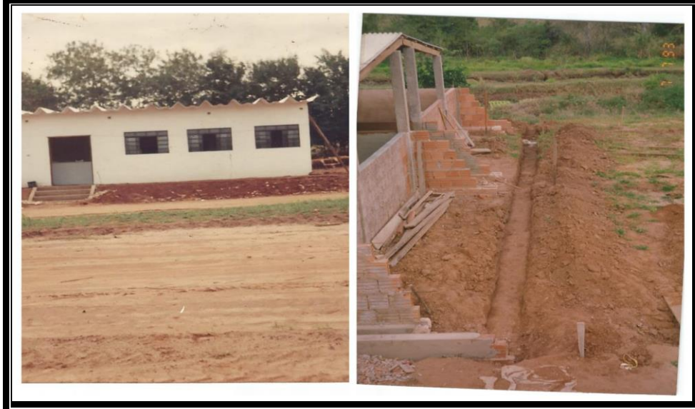
Figura 19: Construção da nova secretaria, direção, sala dos professores e novas salas de aulas 1993 e 1994
