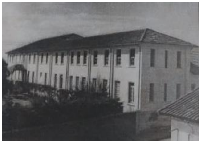
Figura 16: Edifício onde funcionou o INSSC até 1996
