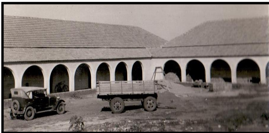
Figura 21: Colégio Educandário Santa Clara em construção
