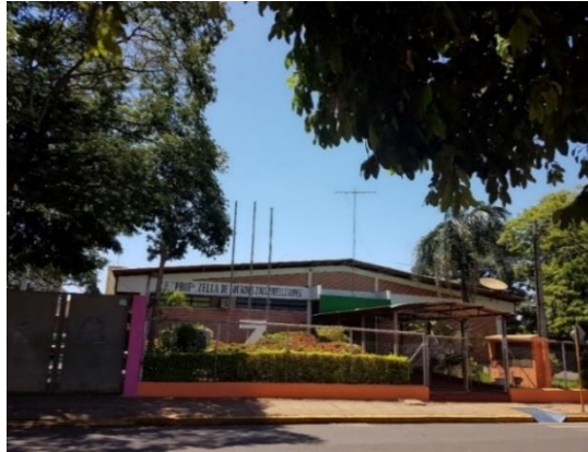
FIGURA 4- Foto - Fachada da Escola/ Portão Lateral
