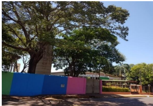
FIGURA 5 -Foto - Fachada da Escola
