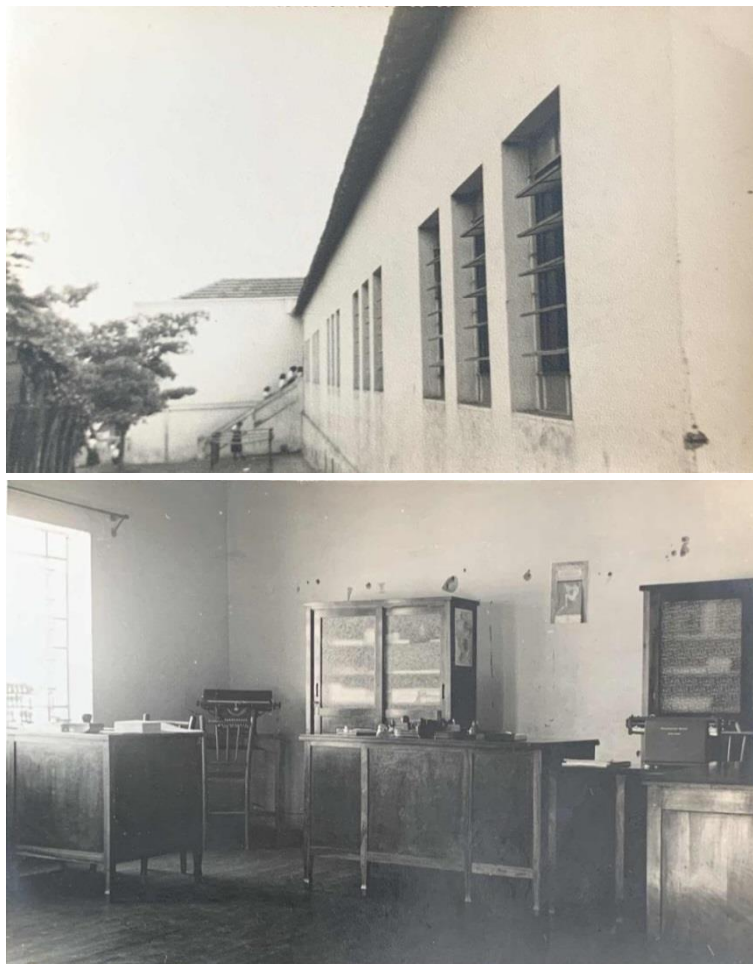
Figura 16 - Sala dos professores e acesso por escadaria externa (Prédio cedido) - ano de 1952
