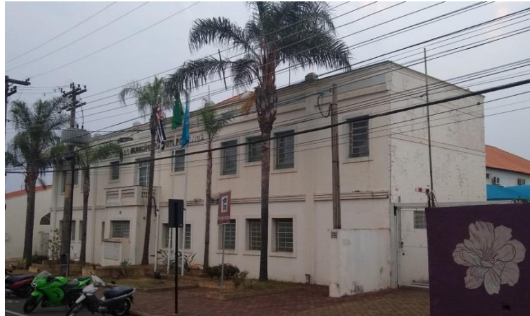
Figura 12 - Fachada do prédio escolar transformado em Paço municipal
