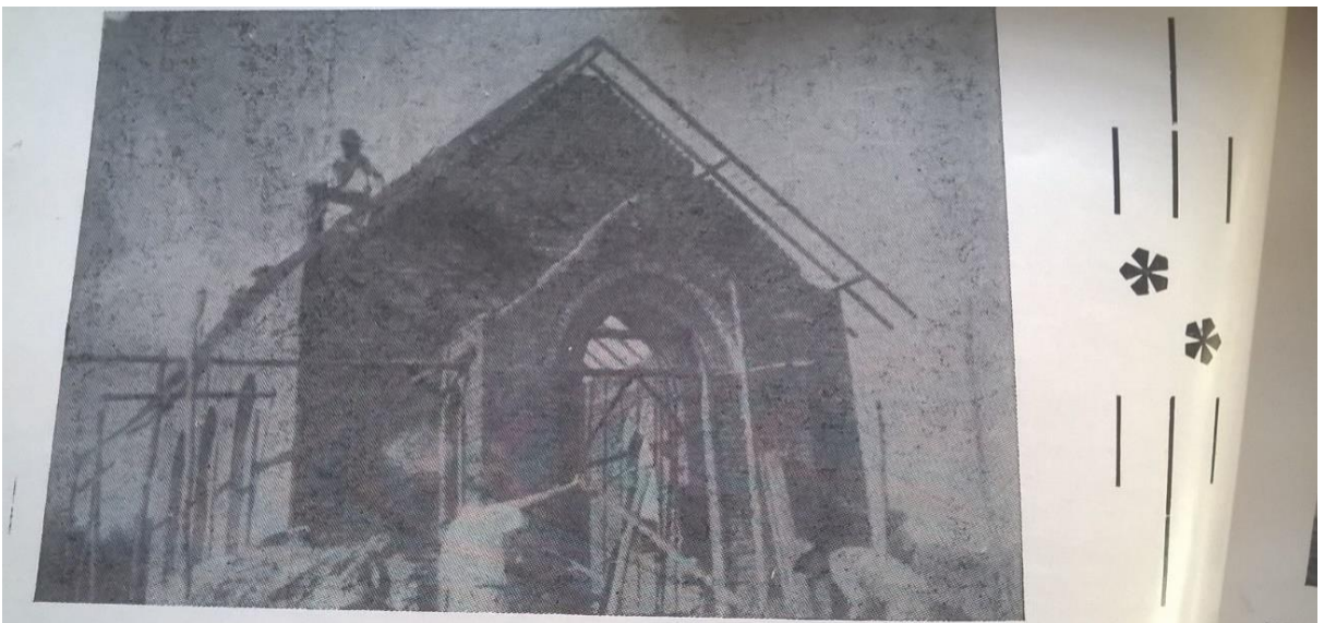
Figura 11. Construção da 1ª Igreja em 18 de março de 1940.
