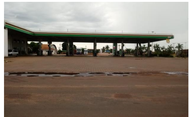
Figura 12: Faixada do Posto São Paulo depois da Reforma na Avenida Ranulfo Marques Leal. Fonte: Acervo Pessoal.
